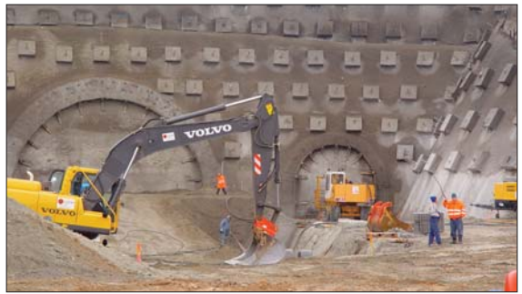
RÜCKBLICK. Das Süd-Portal kurz vor dem Tunnelanstoß am 20. Februar 2004.
